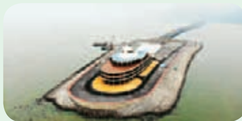
图1-19 港珠澳大桥东人工岛
