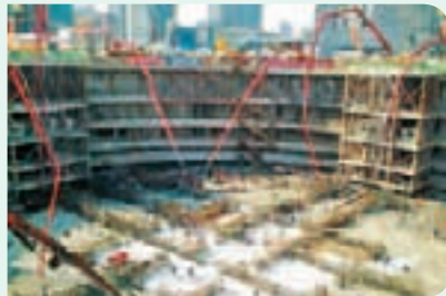
图1-2 上海中心大厦地基浇筑
