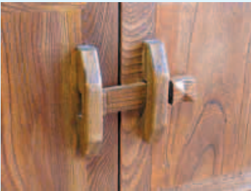
图 1-1 控制门开关的门闩
