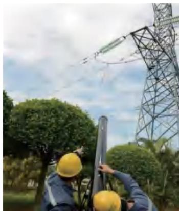
图2-1 用激光炮清除高压线上的异物
