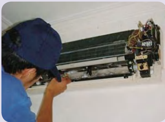
图4-26 检测空调室内机
