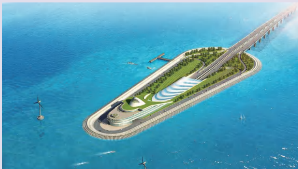
图1-19 港珠澳大桥人工岛
