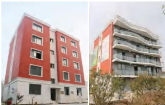
图1-3 三维打印的建筑
