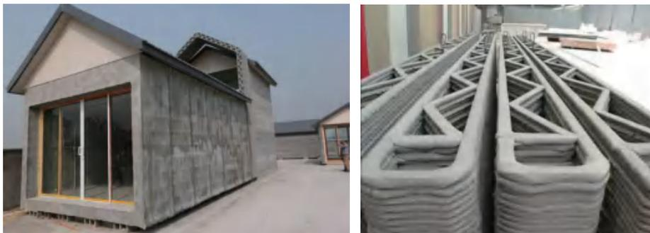
图4-53 三维打印制造房屋
