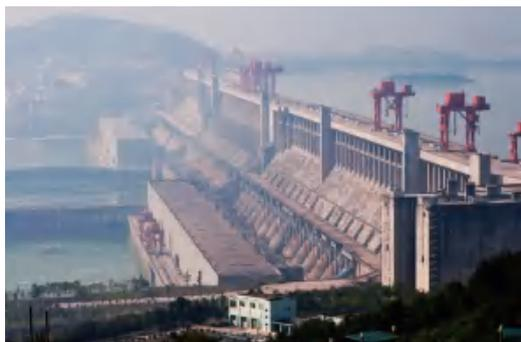
图1-29 混凝土重力坝
