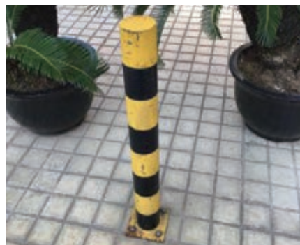
图1-33 安全桩与地面的螺栓连接
