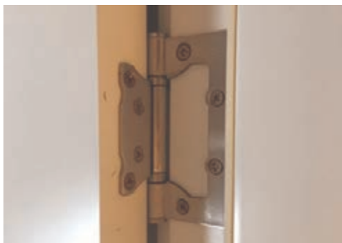
图1-32 门与门框的连接
