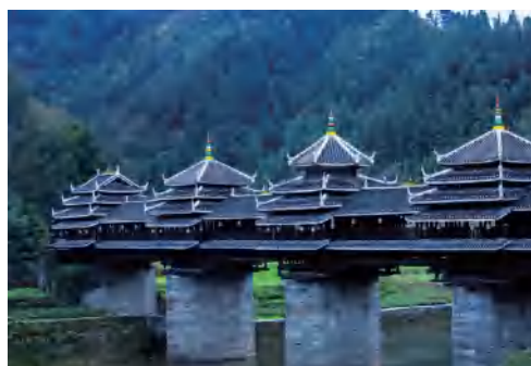
广西三江程阳永济风雨桥
