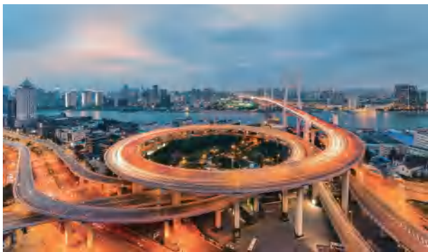
上海南浦大桥
