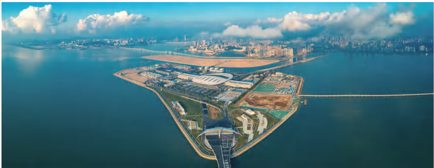
| 港珠澳大桥人工岛
