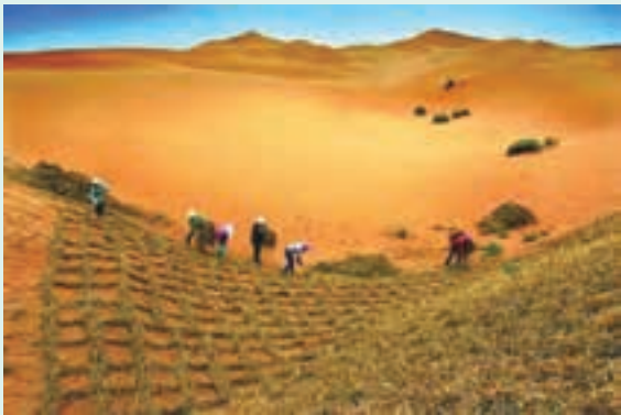
图 5-35 治沙工人在铺设草方格
