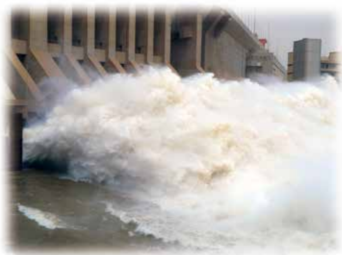
水电站泄洪场景
