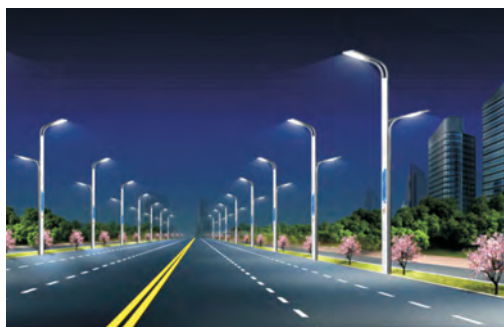
图 5-3-1 自动照明路灯
