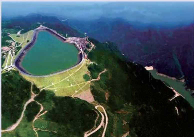
图 5-3-2 浙江省安吉县天荒坪抽水蓄能电站
