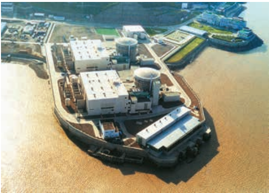
图 6-3-2 秦山核电站全景
