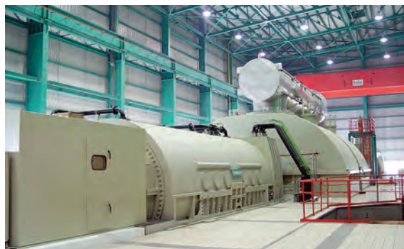
图 7-13 大型交流发电机组
