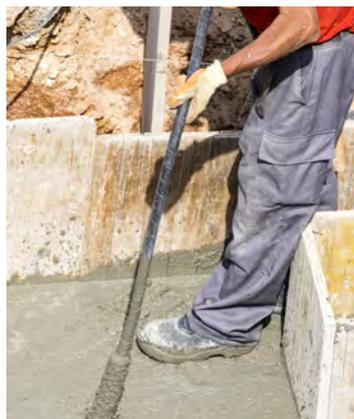
图 2-25 建筑工人用振捣器工作
