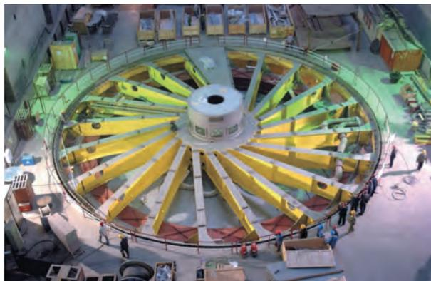
图 7-22 水力发电机的涡轮
