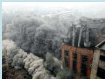
▲ 图 1-5-14 爆破拆除
