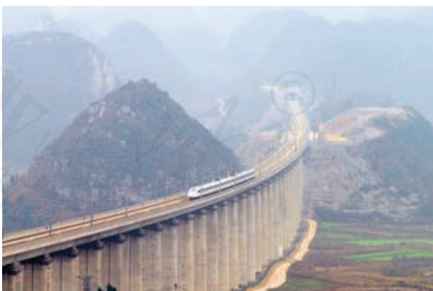
我国西部山区山高谷深，在这里修建高速公路和高速铁路，常常是高架桥梁与隧道相连，工程量大，技术要求高，施工难度大，单位里程建设资金是平原地区的数倍。例如，沪昆铁路桥隧长度占线路总长的比例，贵州段高达81%，云南段也达70%。
