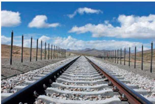
青藏高原日温差大。有些地方在冬春和秋冬过渡时期，土壤层反复冻融。当表层土壤冻结而下层土壤未冻结时，铁路路基不稳定，威胁列车运行安全。在这样的时候，插入地基下面的热棒可排出下层土壤多余的热量，使下层土壤保持冻结状态。
