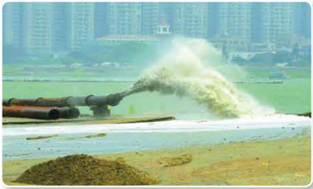
马銮湾4号生态岛吹填现场
