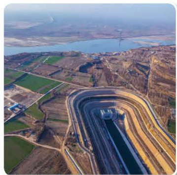
南水北调穿黄工程
