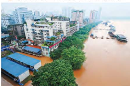
f 洞庭湖地区周边城市遭受洪涝灾害
