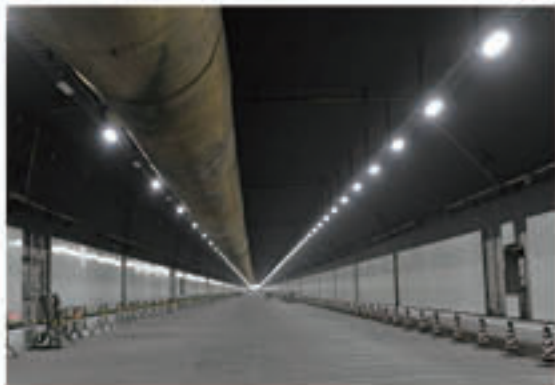
沉管隧道内部
