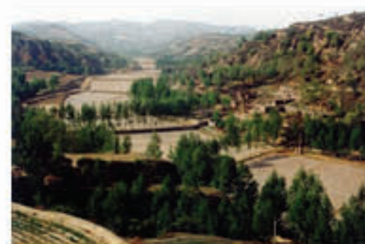
沟谷处打坝淤地
