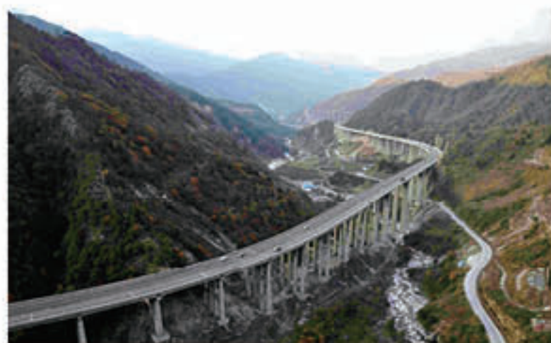
雅西高速公路穿越深山峡谷
