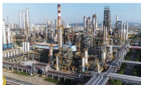
中国石化镇海炼化公司
