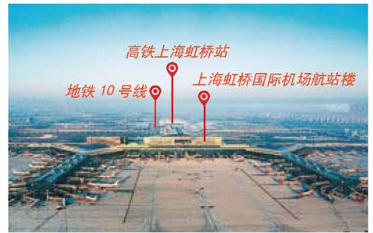
上海虹桥综合交通枢纽
