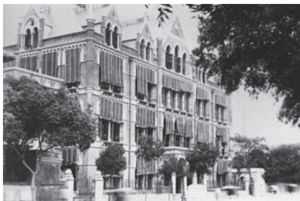
▲ 中国通商银行大楼
