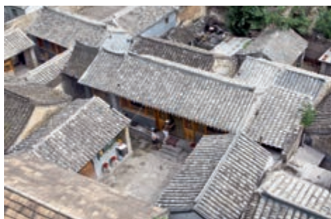
▲ 北京门头沟爨（cuàn）底下村四合院
