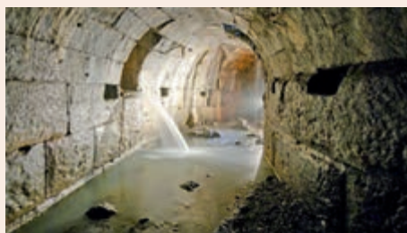
▲ 古罗马的地下排水道
