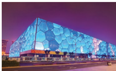
水立方外立面膜结构材料
