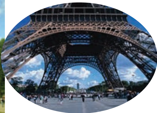
巴黎埃菲尔铁塔底部
