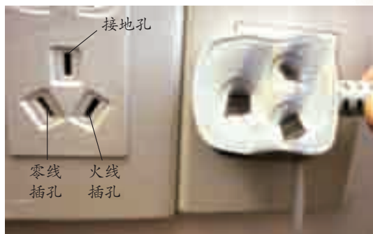
图1-67 三孔式插座和三脚插头
