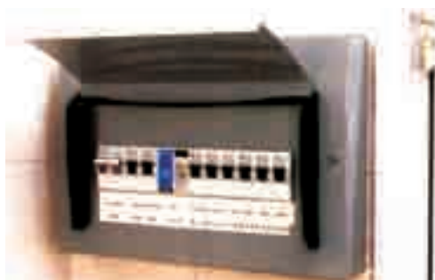
图1-64 安装在电路里的几个断路器
