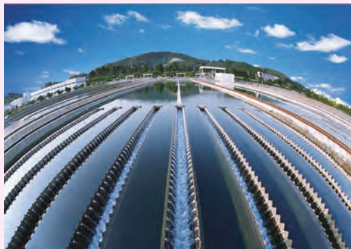
图1-55 自来水厂全貌
