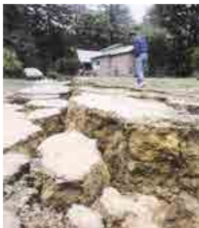
图5-3-4 地震导致的地面开裂
