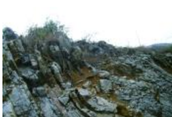
图 3.15 风化崩裂的石头
