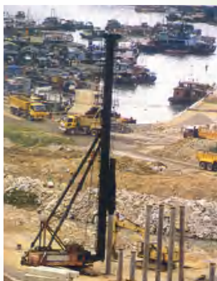
(b) 打桩机能将桩打入地下
