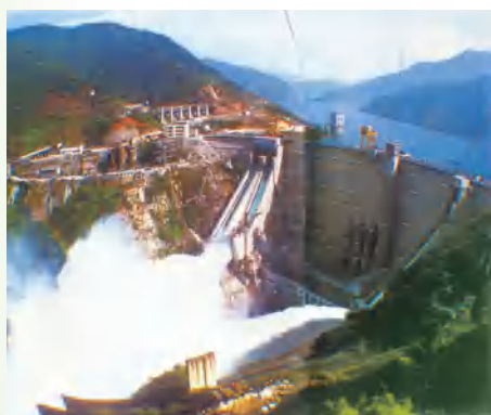
(a) 从水库流下的水能带动水轮机发电
