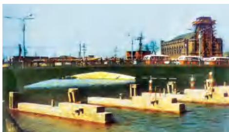
图 2-48 由于过量开采地下水,造成地面沉降而报废的海河老桥的桥墩
