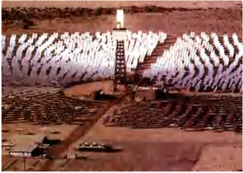
图 18-12 太阳能发电装置
