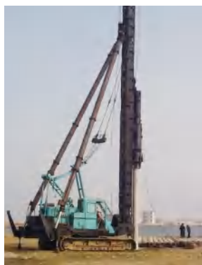
(a) 打桩机上被举高的重锤能将桩打入地下
