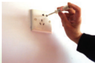
图 9-1-8 用验电笔检验插座的相线
