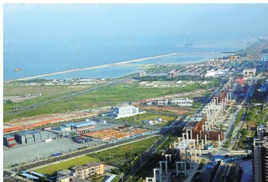
图 7-3-7 建设中的深港现代服务业合作区
