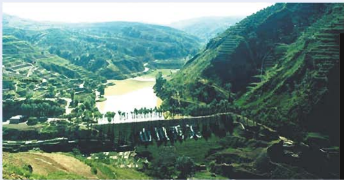
图 7-1-12 陕西省绥德县韭园沟流域骨干坝
