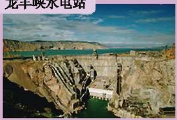
龙羊峡水电站
