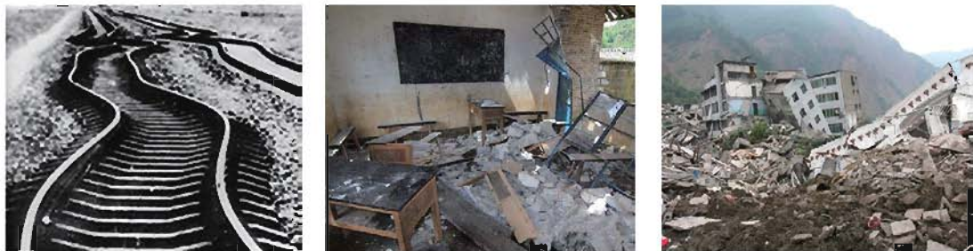
图 2-4-2 地震造成的危害
