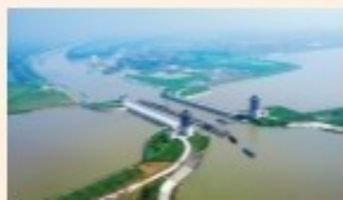
图5-3 淮安枢纽工程
