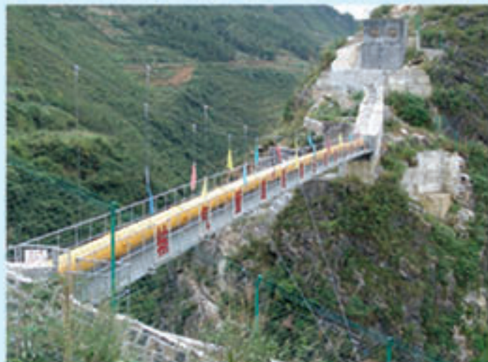
西气东输管道
