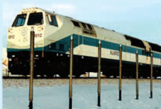
青藏铁路昆仑山口的冻土热棒区
