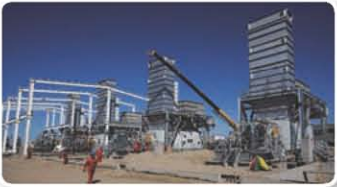
西气东输二线建设
