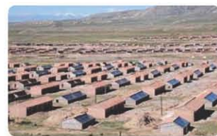
三江源地区移民安置工程
