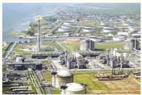
尼日利亚的石油园区
