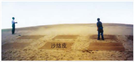
沙漠治理——化学法固沙
