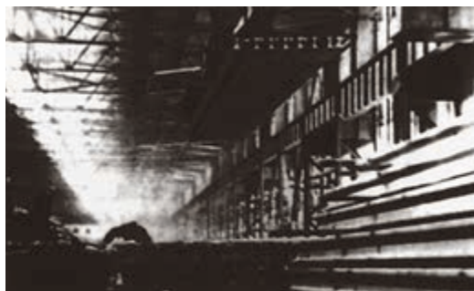
鞍山大型轧钢厂
